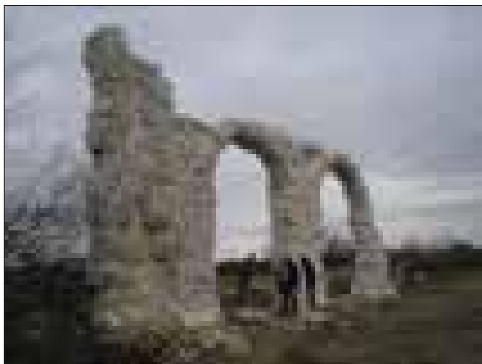
Fig. 3. Gli archi della basilica di Burnum .
