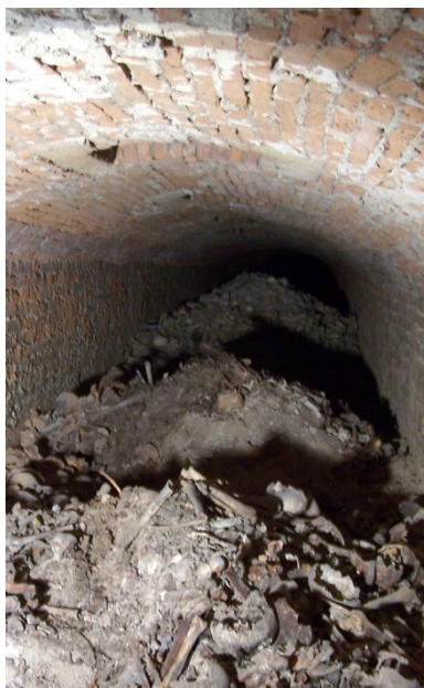
Figura 50. Camera O, vista da sud. Si osserva la presenza di cumuli di ossa in corrispondenza delle bocche al piano pavimentale della cripta.
