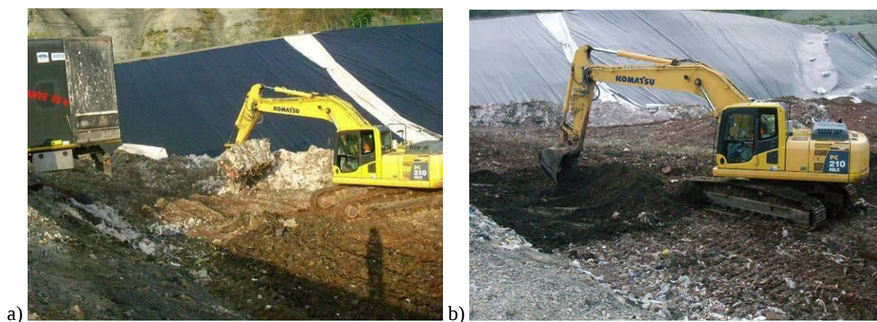
Figura 22 : Fasi di abbancamento dei materiali in entrata; a): posizionamento di rifiuti assimilabili agli urbani, conferiti in balle; b) stesa di materiale granulare, che viene successivamente compattato mediante gli automezzi in dotazione all'impianto.
