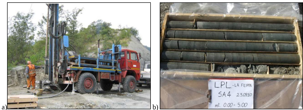
Figura 11 : a) Fasi di perforazione di un sondaggio a carotaggio continuo; b) Cassetta contenente la parte più superficiale del sondaggio SA4; si noti la presenza, a partire dal p.c. e fino a circa 60 cm di profondità, della copertura superficiale e del substrato alterato.
