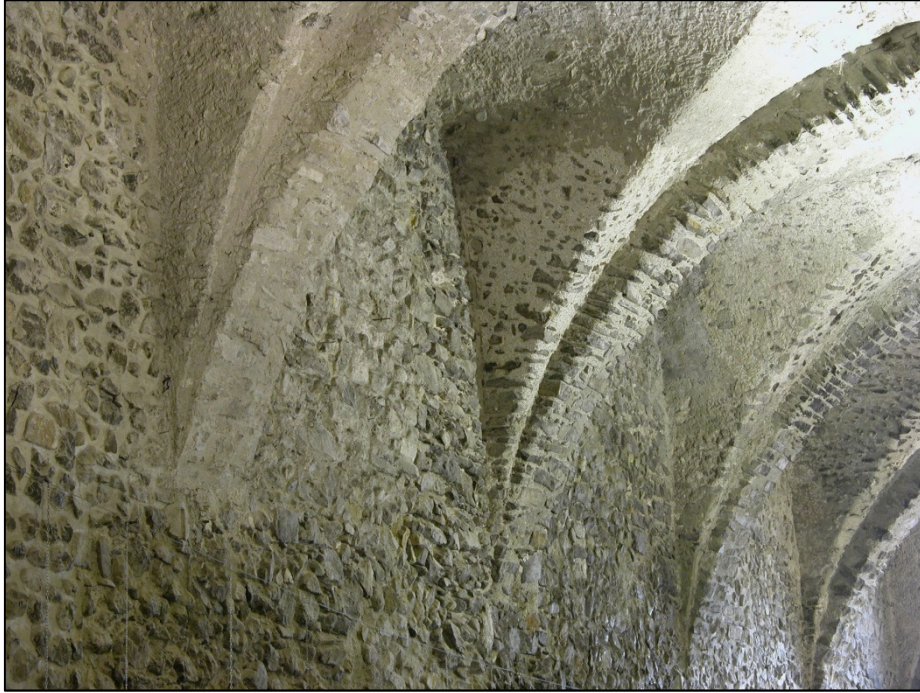
Figura 8 – Particolare della muratura dell'Arsenale
