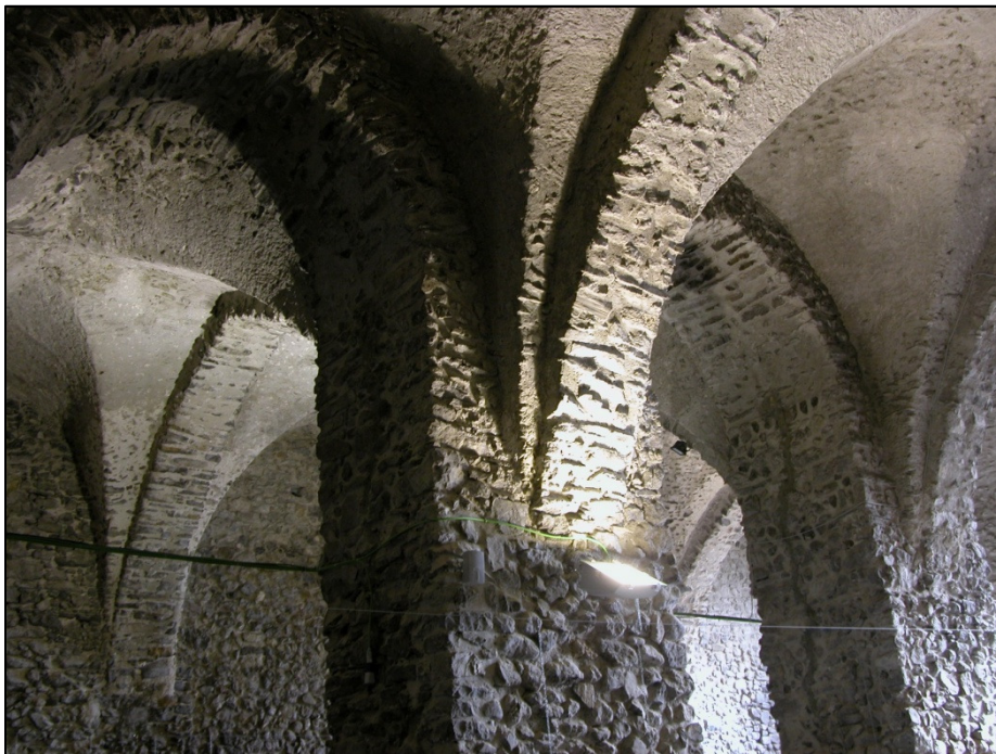
Figura 9 – Particolare delle volte dell'Arsenale
